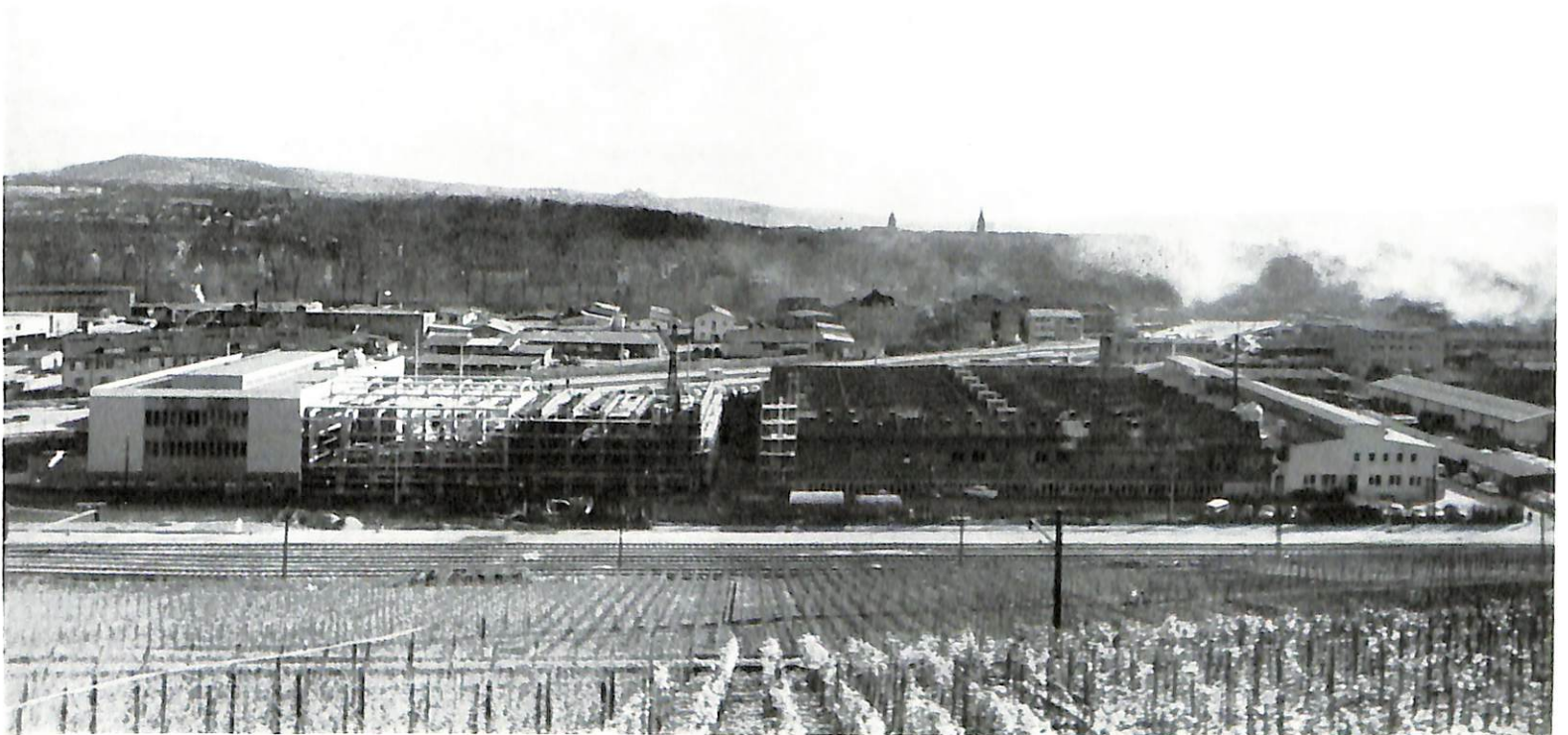
37 Werk II Bad Cannstatt
